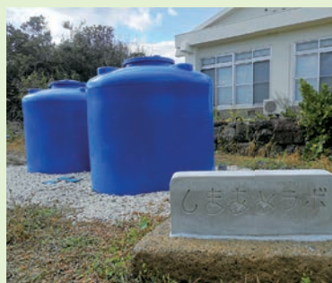
大型雨水貯留槽
